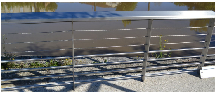
AMÉNAGEMENTS DES QUAIS - Libourne (33) Agence TER (75)
