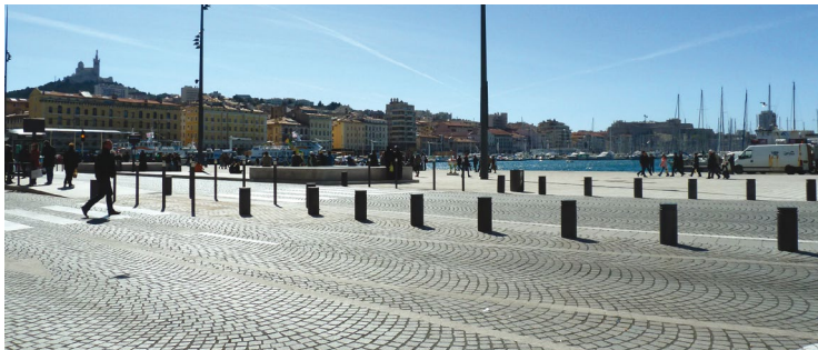
VIEUX PORT - Marseille (13) Architecte FOSTERS & PARTNERS (Londres)
