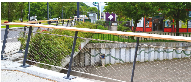
TRAMWAY DE GRENOBLE - Grenoble (38) Architectes GAUTHIER CONQUET (69)
